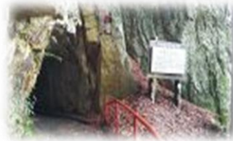
木場トンネル
